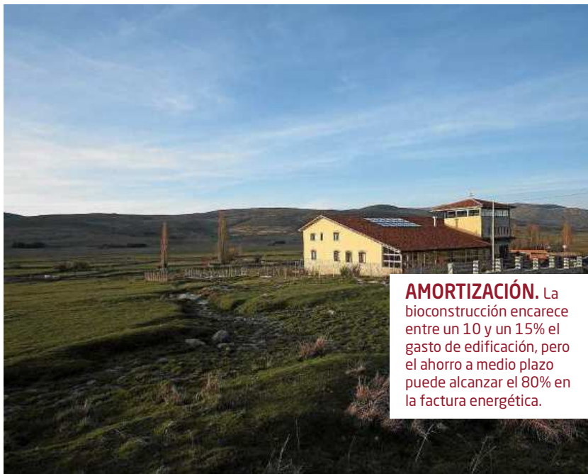
Los paneles solares y una caldera de biomasa calefactan esta granja escuela situada en el Valle del Alberche.
