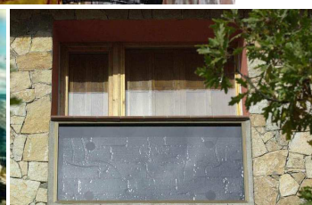
Arriba, paneles solares en Fábrica Cabrera, en la Sierra de Gredos y muros trombe de este alojamiento rural abulense.
