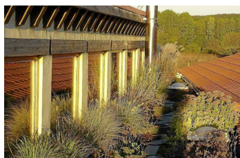
El techo verde protege de insolaciones estivales y heladas invernales. A la derecha, construcción de Casas Enterradas en Palencia.
